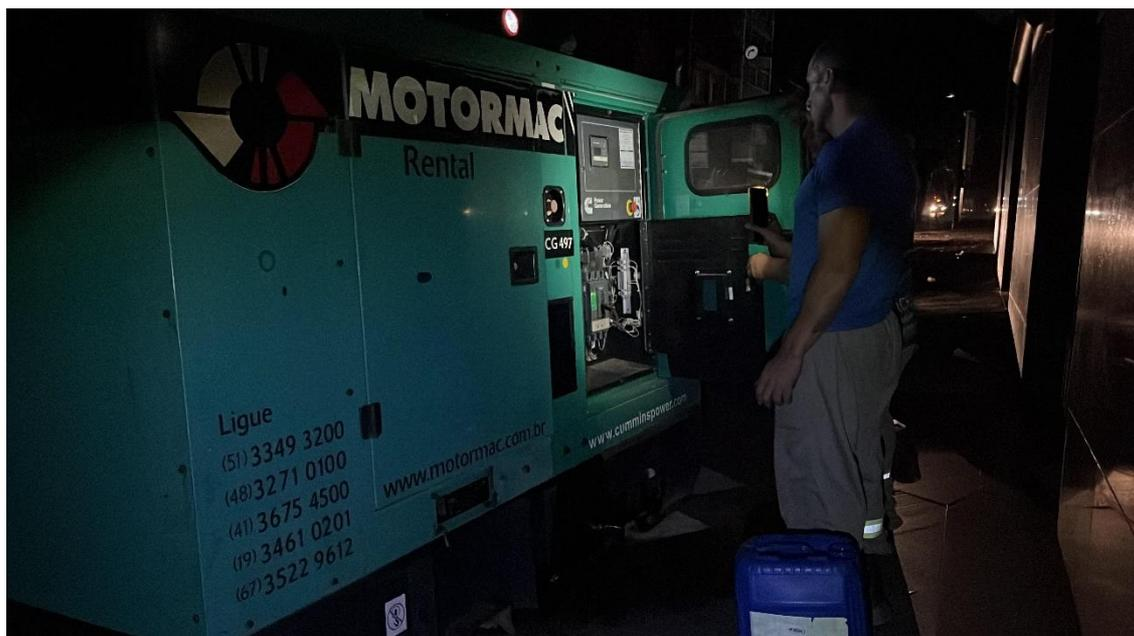
Foto 3.2.5 – Equipe de eletricitas preparando a ligação dos cabos até o QGBT.
