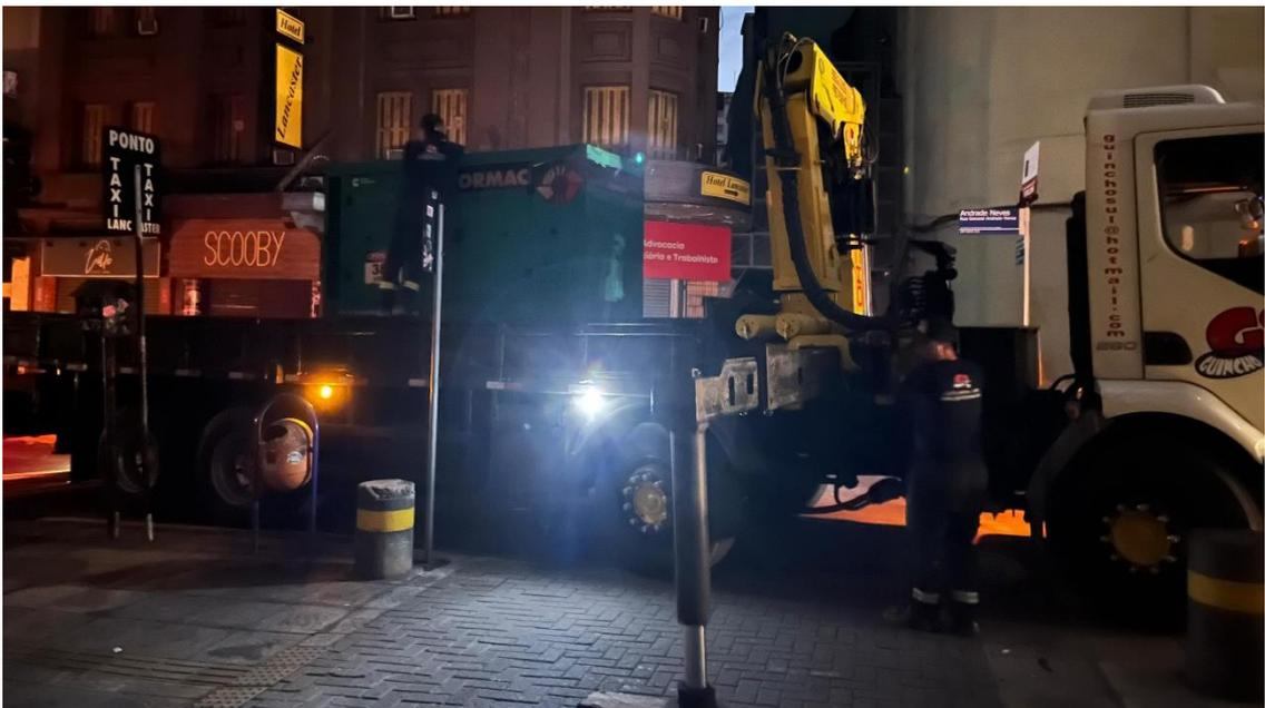
Foto 3.2.2: Segunda tentativa de descarregamento do gerador. Realizada com sucesso.
