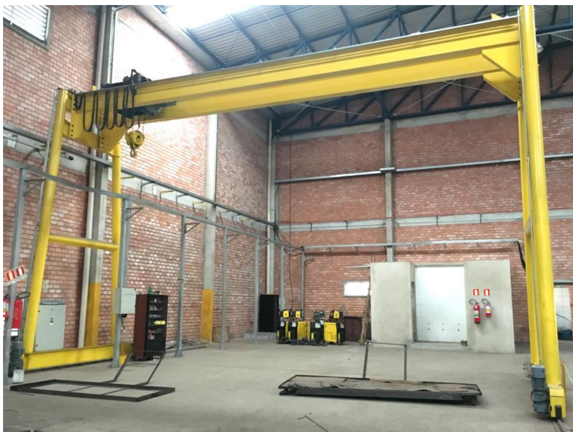
Figura 5: Ponte rolante 5,00 t x 12,00 m
